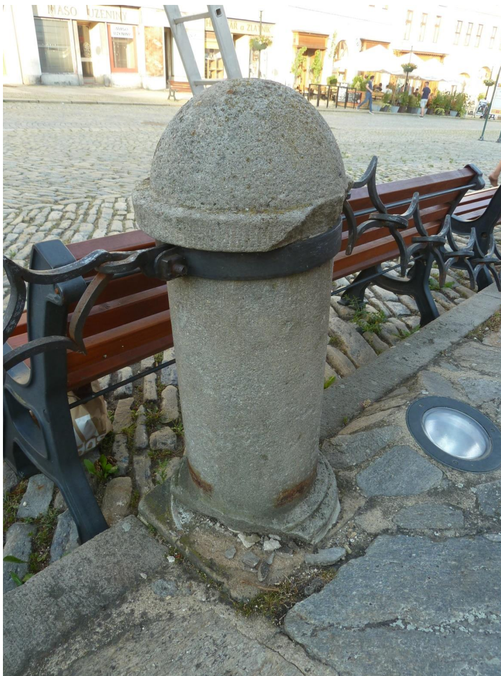
Dlažba s obrubou a sloupky. Poškozená hlavice a patka sloupku (sloupek č.5).
