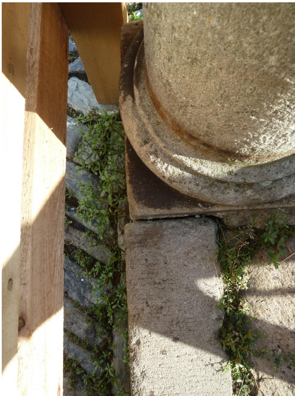
Dlažba s obrubou a sloupky. Vysunutá uvolněná obruba (u sloupku č.4).
