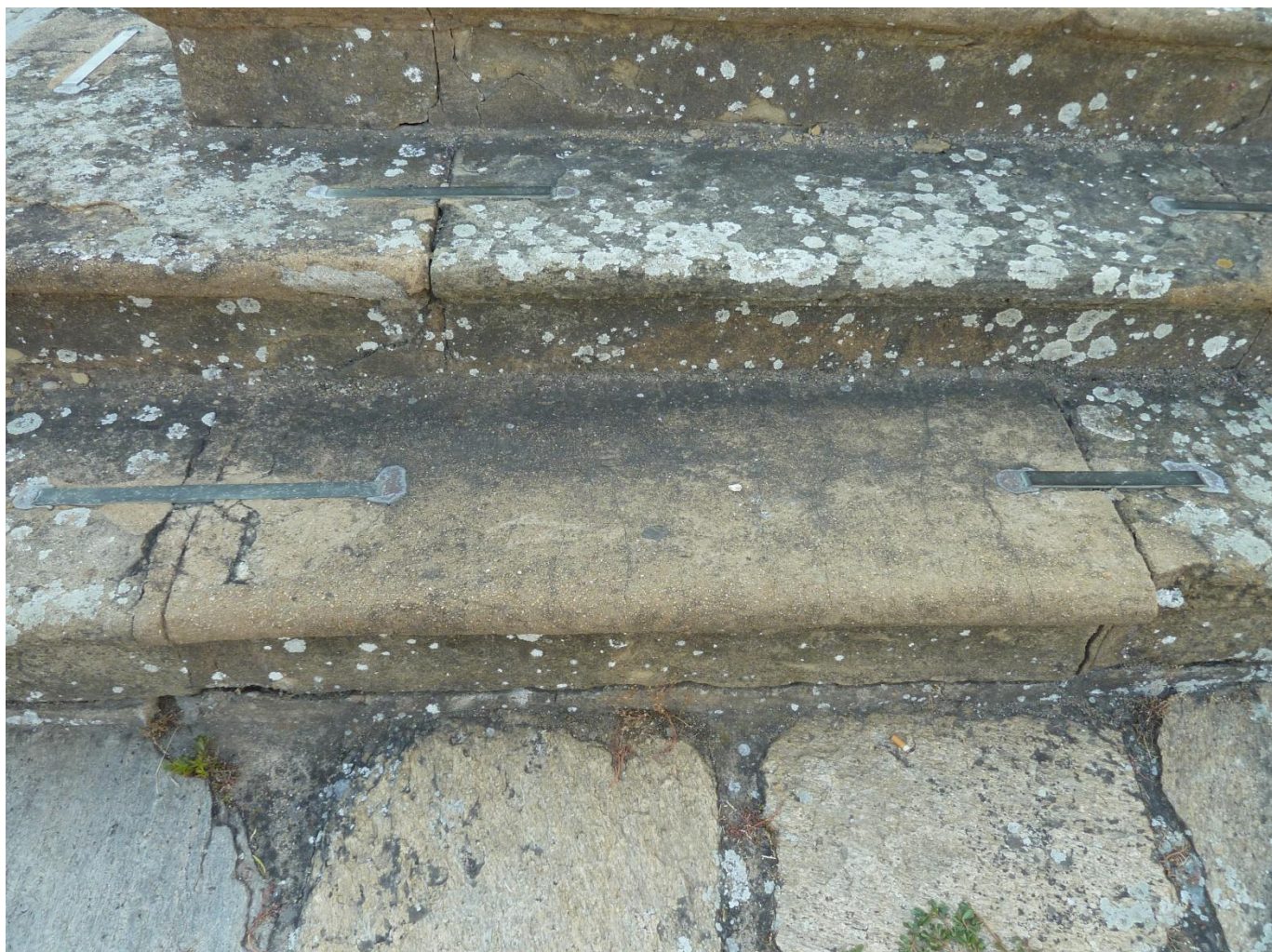
Stupňová podnož – čelní strana (SZ) Celoplošně překrytý stupeň cementovou maltou.
