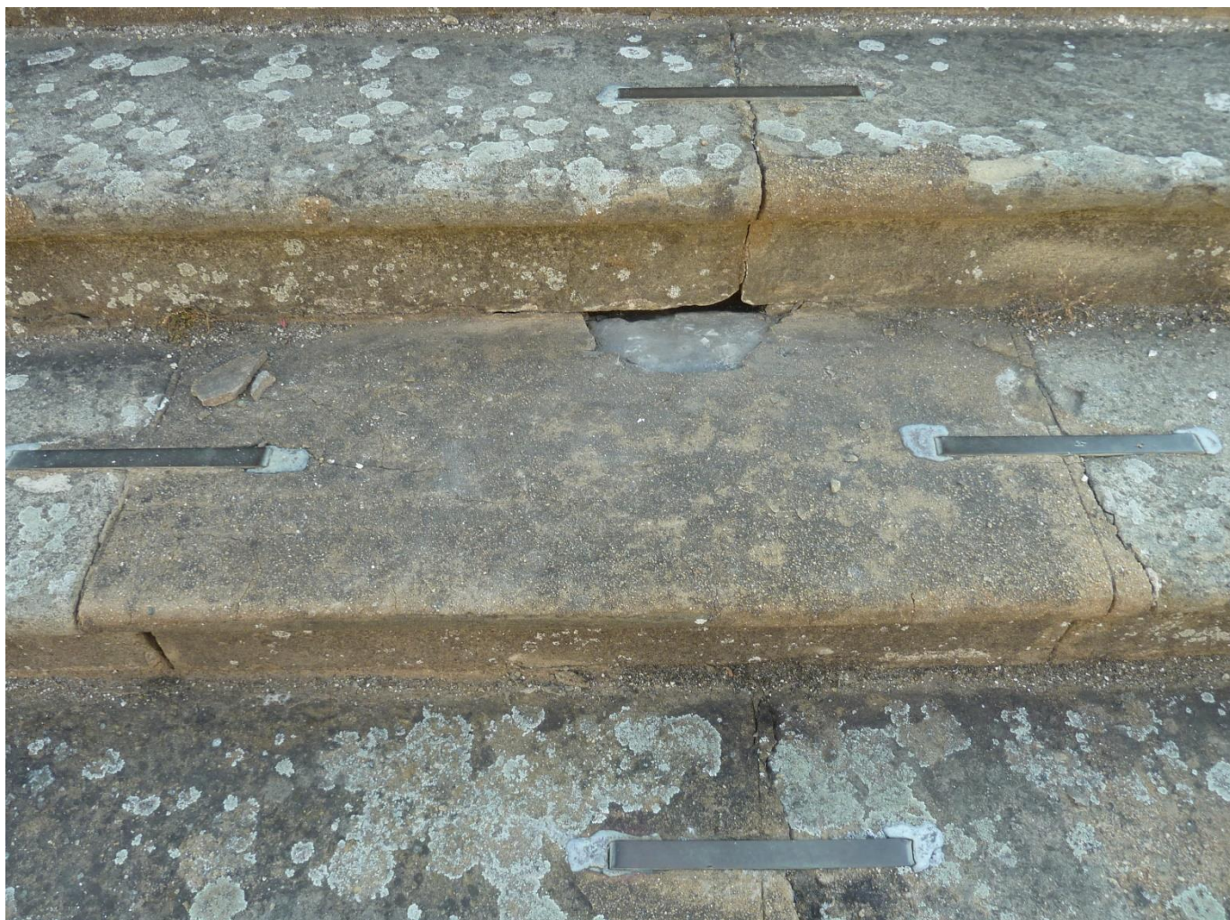
Stupňová podnož – pravá strana (JZ) Celoplošně překrytý stupeň cementovou maltou.
