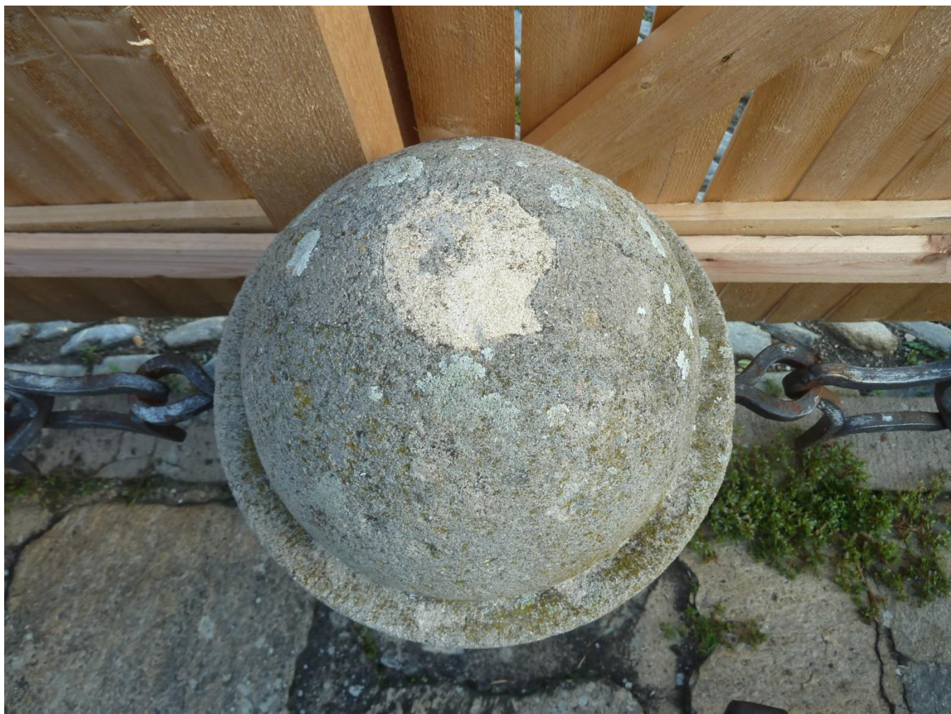
Dlažba s obrubou a sloupky. Tmel na hlavici sloupku (sloupek č.3).
