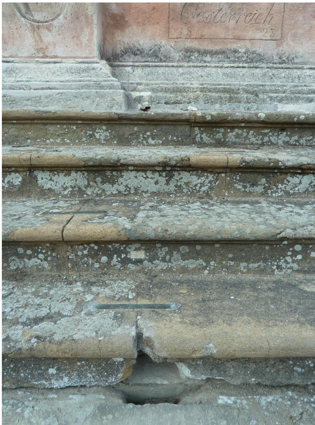
Stupňová podnož – levá strana (SV) Sonda ve spáře v úrovni prvního stupně podnože.
