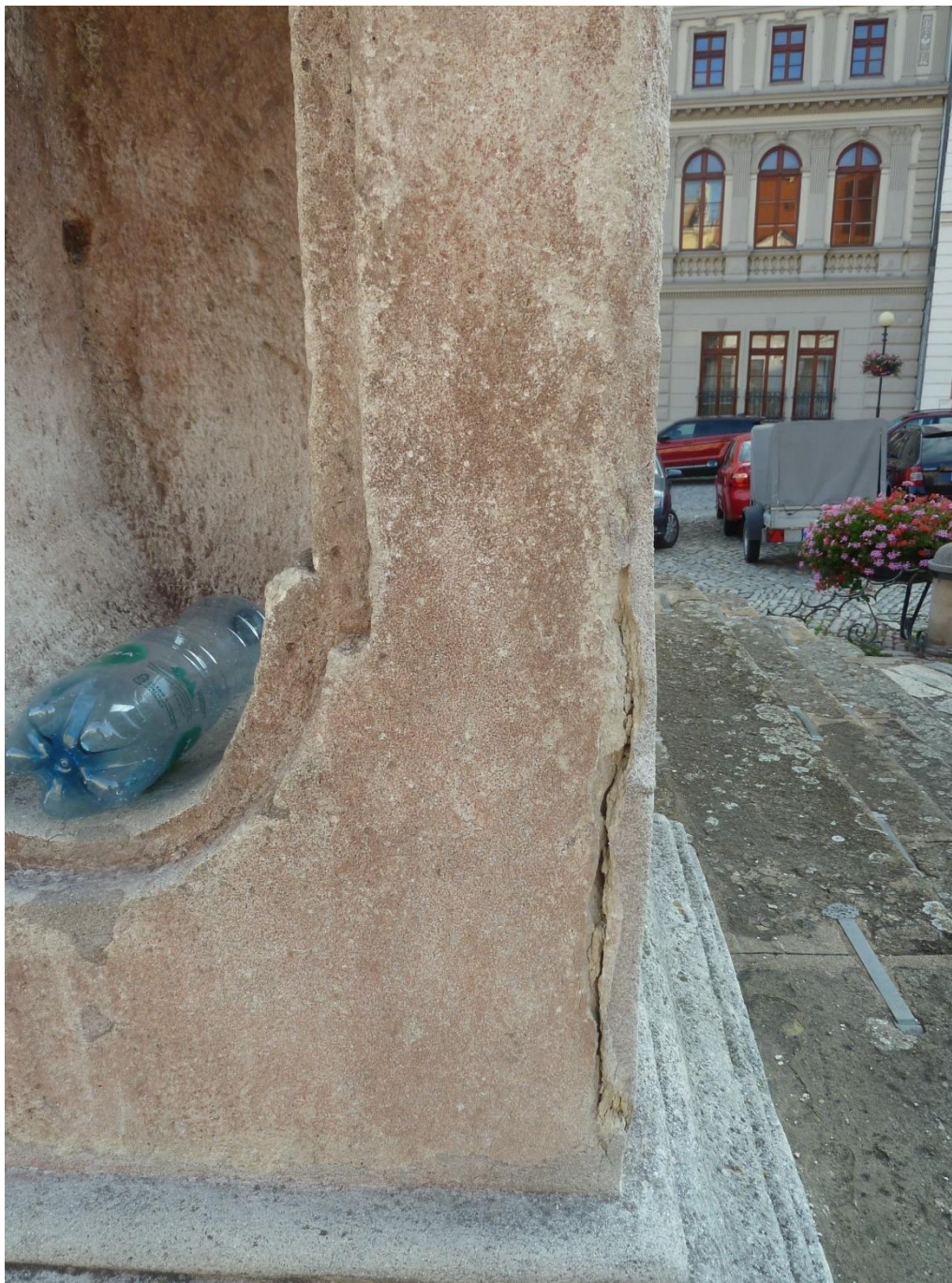
Podstavec – pravá strana (JZ) Pravé nároží. Uvolněná vrstva tmelu.
