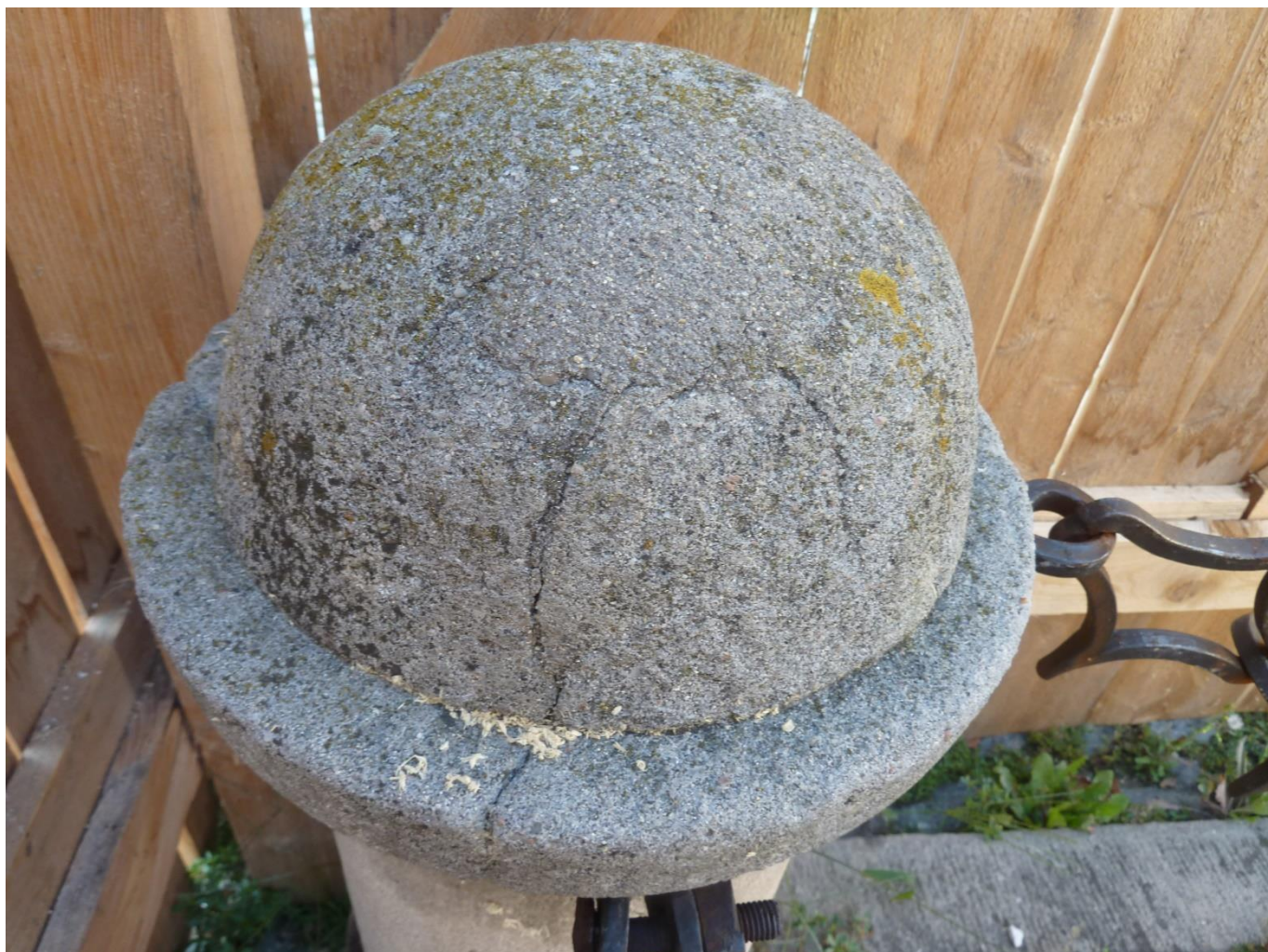
Dlažba s obrubou a sloupky. Praskliny v hlavici sloupku (sloupek č.9).
