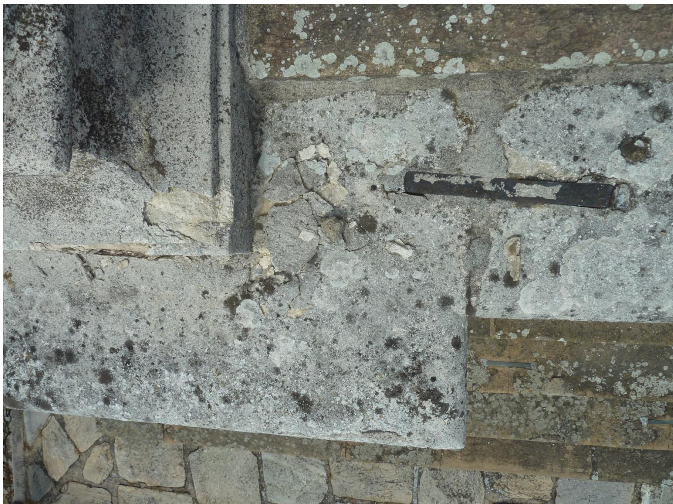
Podstavec – levá strana (SV) Odpadávající vrstva tmelu na horní ploše římsy.
