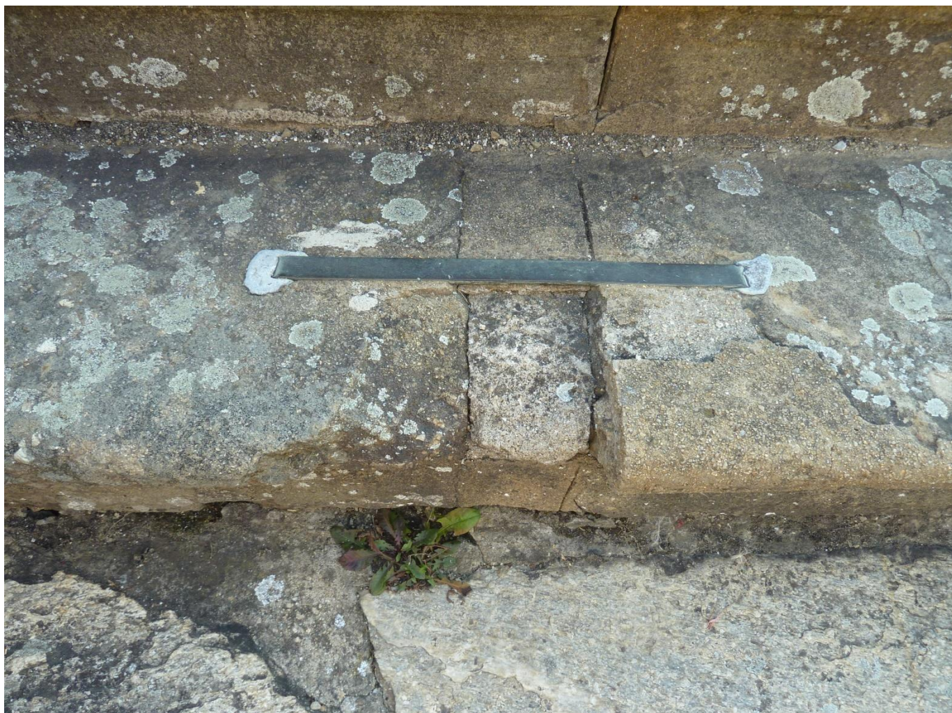
Stupňová podnož – pravá strana (JZ) Betonová výplň široké spáry mezi kamennými stupni.
